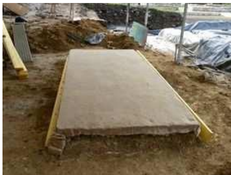
Deuxième entoilage avec de la toile de jute
